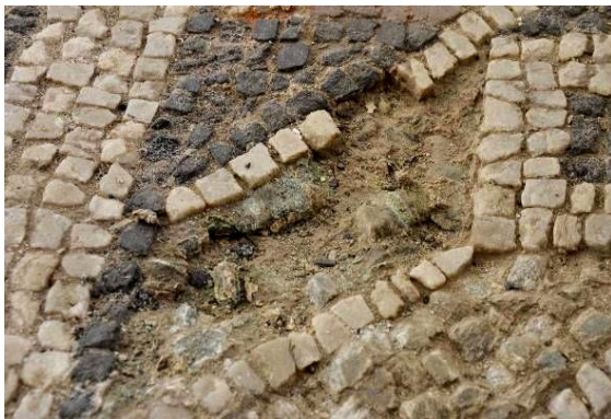
67. kép A savariai Aula Palatina in situ mozaikpadlójának „csatári” zöld kőből készült részletén látszik a környezetéhez képest látványos romlás.
