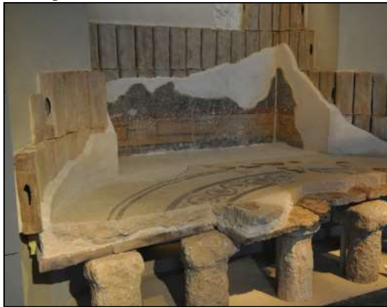
20/a. kép. Fal és padlófűtés bemutatása. Herodium, Izrael.
