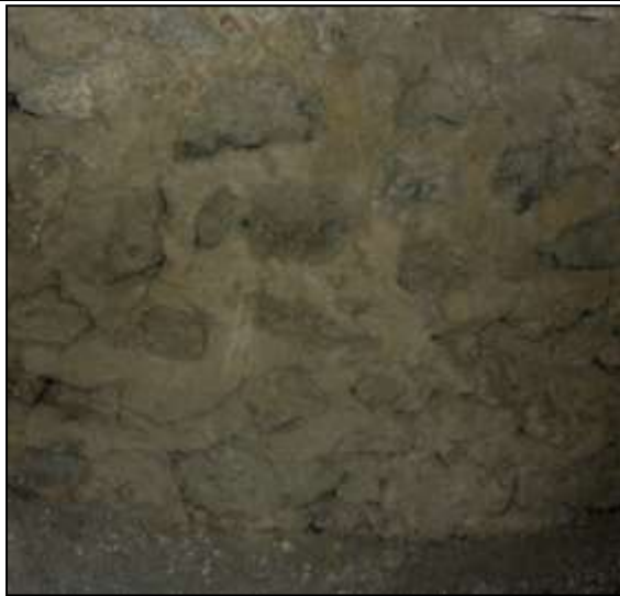
18. kép. Kőből épített falazatra felhordott kiegyenlítő sárhabarcs. ( Pompeii Reg. IX, Insula XII. Foto: H.E.)
