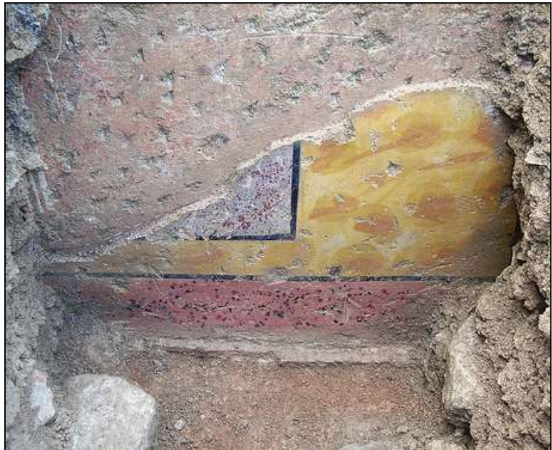
30. kép. A tapadás biztosítása végett felpikkelt téglaporos alsó vakolatréteg. (Fürdőépület, Truckle Hill, Anglia)
