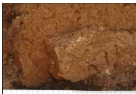
38. kép. Kétrétegű sárvakolat oldalfalon. Gorsium , XCLV. épület. (Foto: H.E.–K.Zs.)
