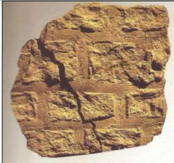
19. kép. Faragott terméskőből rakott falazat és a fugák lenyomata az elsőként felhordott vakolatréteg hátoldalán. (Périgeaux, musée du Périgord à Périgueux. Foto: A. Barbet, Barbet 1997, Fig. 14.)
