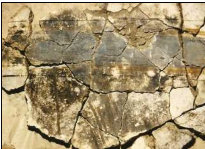
236. kép. Feltehetően fáklyák okozta kormosodás, valamint beázás következtében kialakult elszíneződés a felszínen. (K/Sz–Vt. I/1. mennyezete, Brigetio . Foto: H.E.–K.Zs.)
