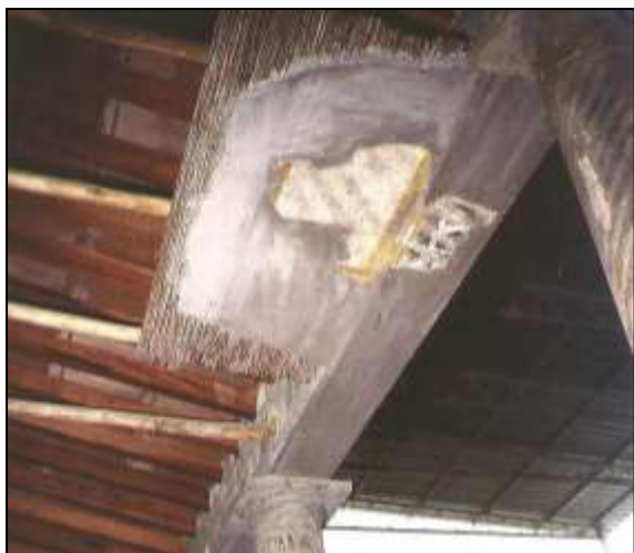
22. kép. Rekonstruált nád stukatúr mennyezet. Villa di Poppea, Oplontis. (Foto: A. Barbet, Barbet, 1997, Fig. 22.)
