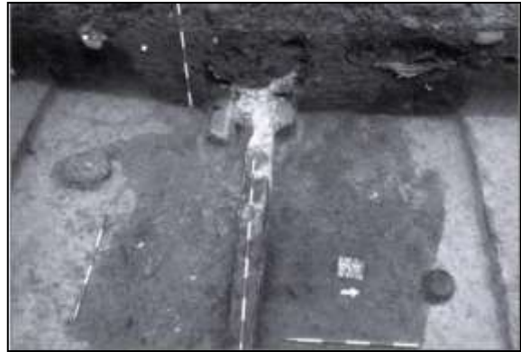
7/b. kép. Aquincumi késő római mészégető kemence tüzelőnyílása és munkagödre 2005-ben (Bp. III. ker., Pók u. – Duna-part – Római part, Hrsz.: 23789) (Láng 2006, 3. kép)
