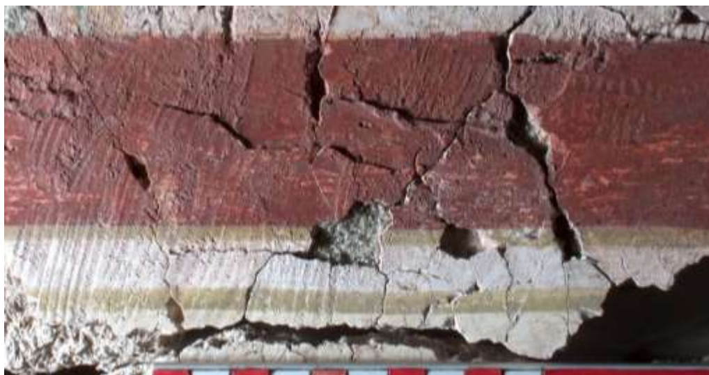
217. kép. Az oldalfal intonaco rétege ráfed a mennyezet intonaco jára. ( Gorsium , XL. épület kis helyisége. Foto: H.E.–K.Zs.)
