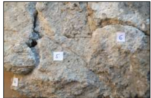
48/b. kép. Az intonaco felől számolt 4., 5. és 6. arriccio réteg. (Foto: H.E.–K.Zs.)
