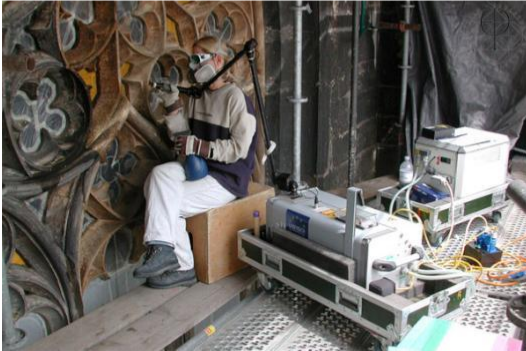
1. kép: A bécsi Szent István székesegyház lézeres tisztítása [15]
