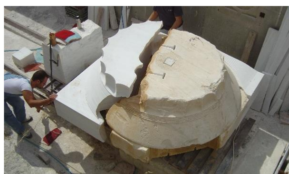
12. kép A Parthenon egyik oszloplábazatának törésfelületére illesztett betét felhelyezése, Akropolisz, YSMA, 2006.
