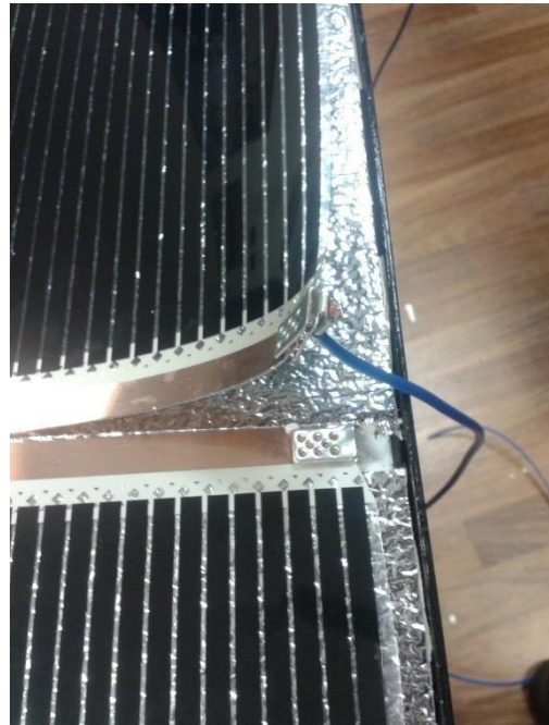
Hőtükörfólia és termosztát az infrafilm alatt
