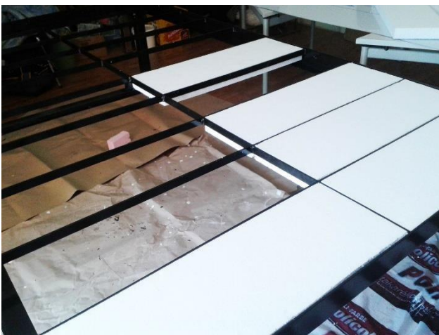
A szerkezet Hungarocell szigetelése és a Purhabos rögzítése a bordákhoz
