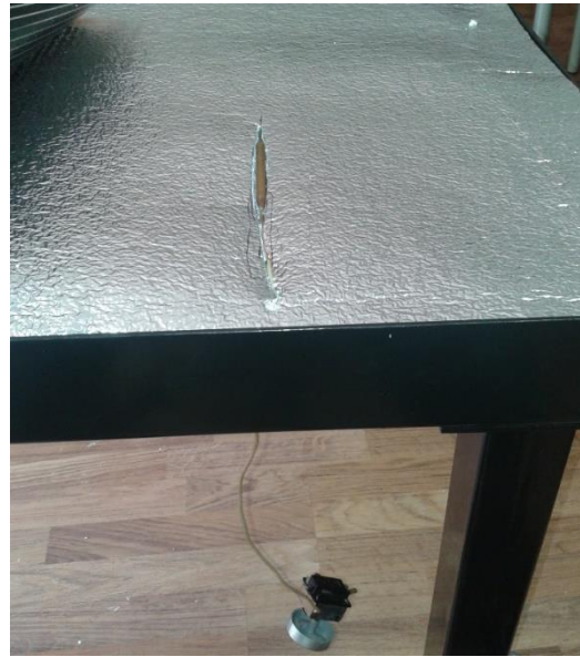
Hőtükörfólia és termosztát az infrafilm alatt
